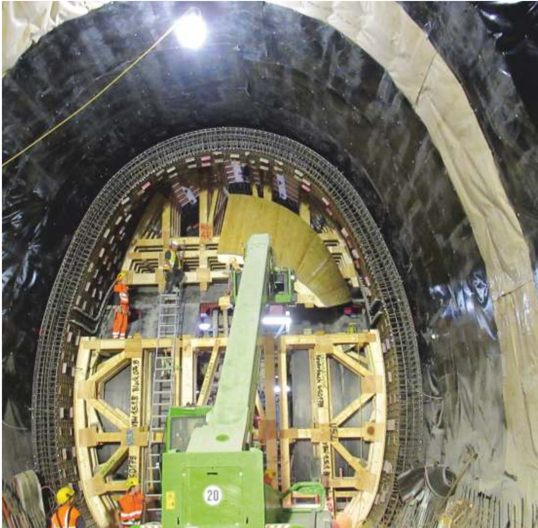
Die Sonderschalung im Tunnel wird montiert. Foto: Peter Maile
