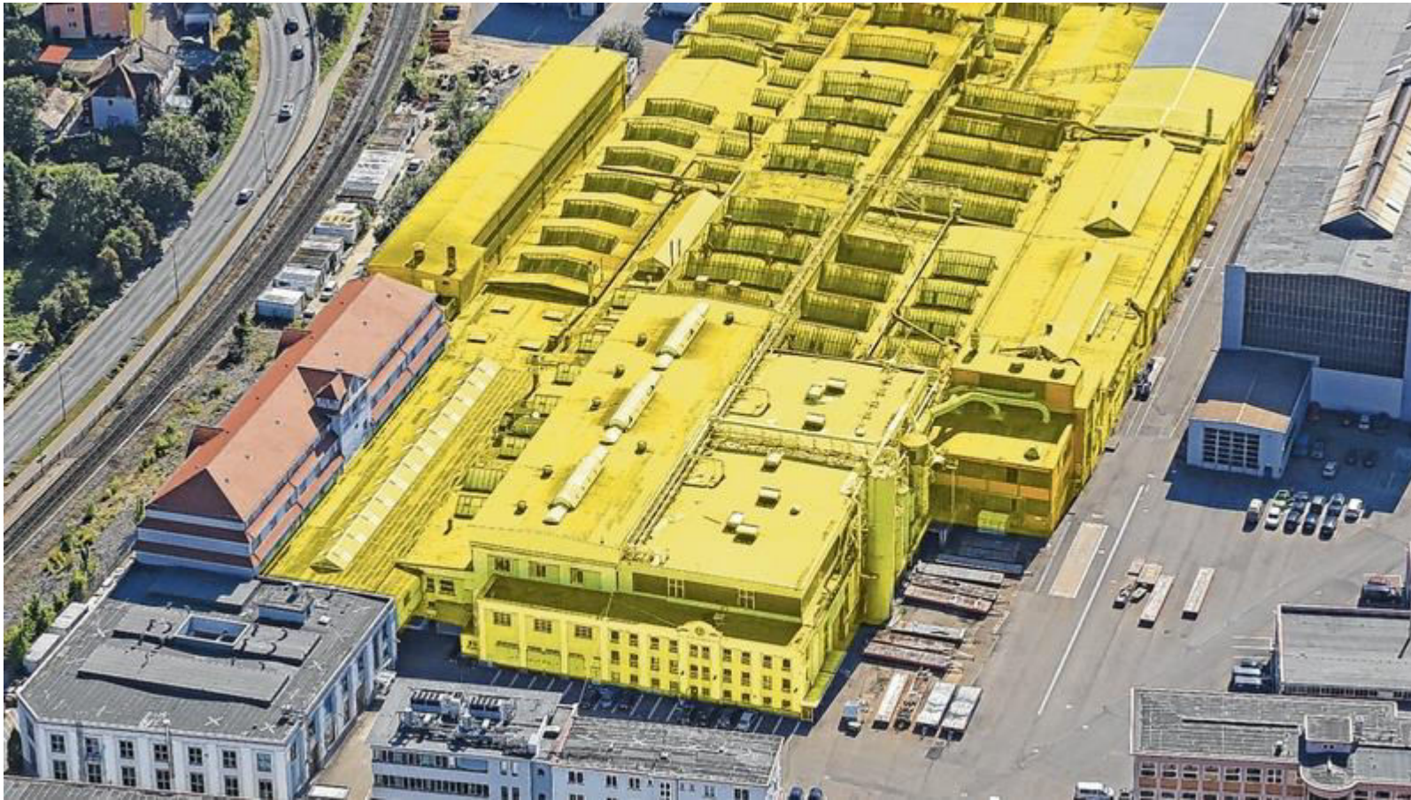
ABRISS Alte Voith-Gießerei vor dem Abbruch – denkmalgeschützter Teil bleibt erhalten Es wird ein halbes Jahr dauern, bis der gewaltige Industriekomplex verschwunden ist. Nur der denkmalgeschützte Teil
