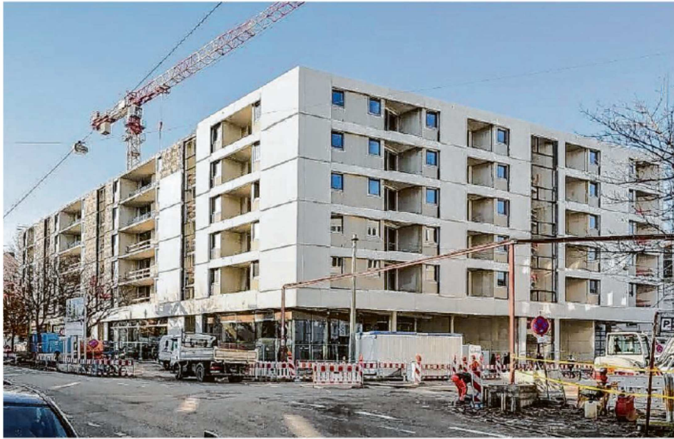
Wohnungsmangel herrscht auch in Ulm. Die UWS baut, wie hier beim inzwischen fertiggestellten Projekt in der Söflinger Straße, bezahlbare Mietwohnungen. Außer ihr bauen aber zu wenige. Foto: Matthias Kessler
