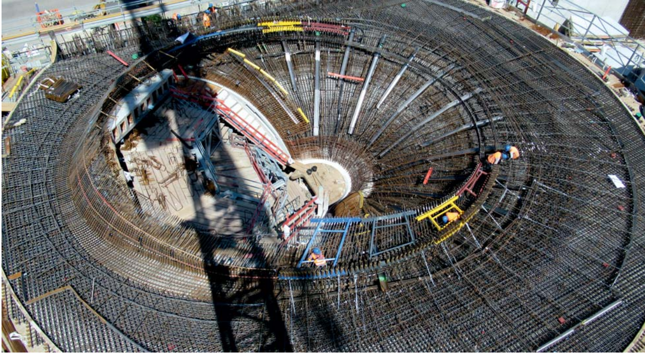
Eisenflechter auf der Baustelle Stuttgart 21 Foto: Peter Maile
