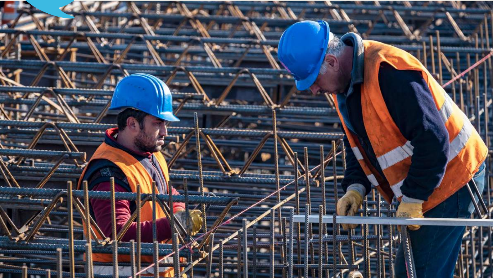
Eisenbieger auf einer Baustelle des Bahnprojekts S 21 Bild © Joachim E. Röttgers, www.graffiti-foto.de
