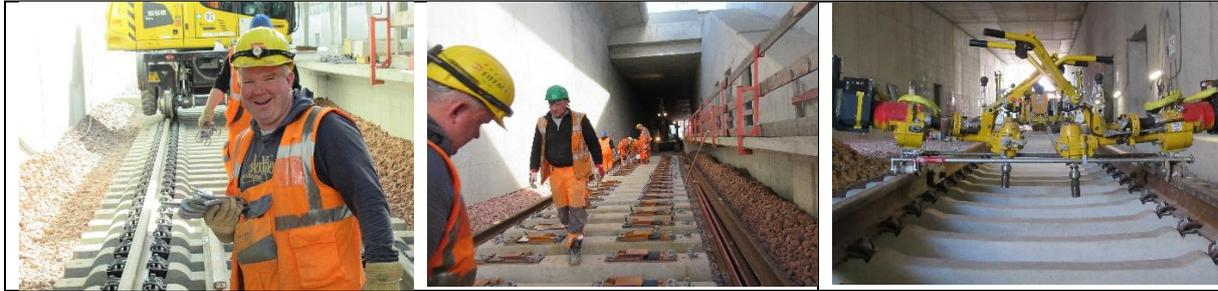
In der Zwischenzeit kamen die Kollegen mit der Stopfmaschine über das Bahnnetz angefahren und haben den Schotter verdichtet und die Gleise absolut (auf die Höhe) ausgerichtet. Diese sind wieder weitergefahren und die Schweißer verbinden nun die Schienen. Der nächste Schritt: Oberleitungen werden eingezogen und der Innenausbau kann beginnen.
