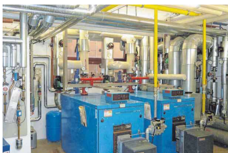
Die Heizzentrale an der Sechta-Ries-Schule wird in den Sommerferien saniert.
